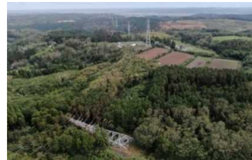
台風15号により倒壊した鉄塔
