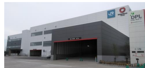
【DPL札幌レールゲート】
