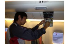
客室内の照明の交換
