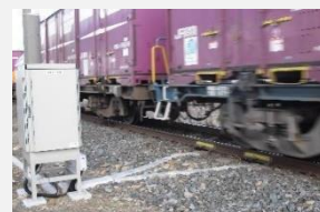
▲輪重測定装置
